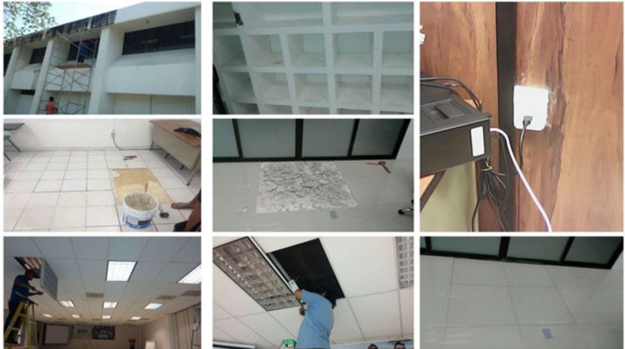
Dibujo 10. Trabajos varios de mantenimiento preventivo y correctivo
